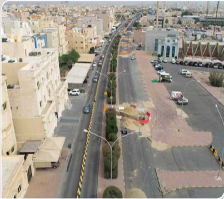
أعمال الخدمات- شبكة مياه الأمطار اعمال الجاليات بمنطقة الصباحية
