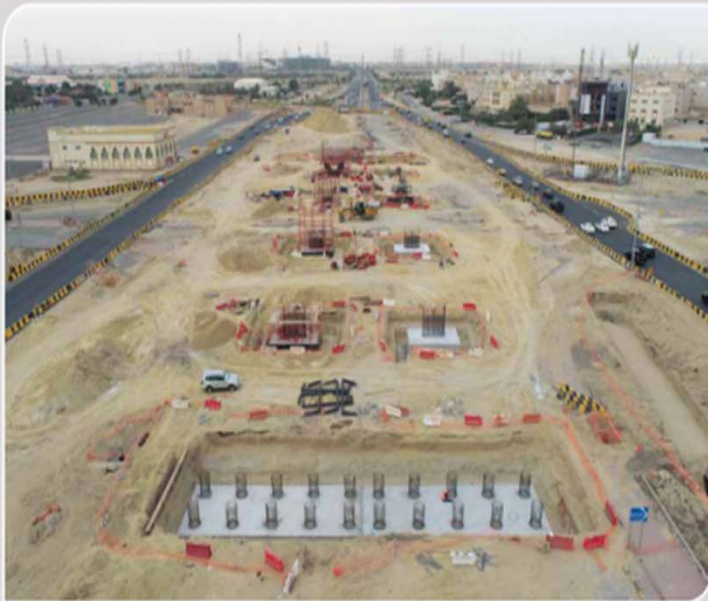
أعمال الجسور-اعمال قواعد أعمدة الجسور - بتقاطع 26
