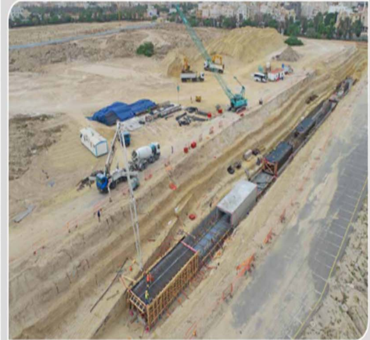
أعمال الخدمات - أعمال مجرور صرف مياة الأمطار - بتقاطع 16
