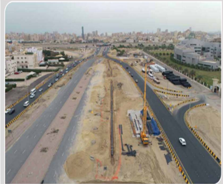
اعمال شبكة الهاتف -تمديد خطوط الهاتف بتقاطع 26
