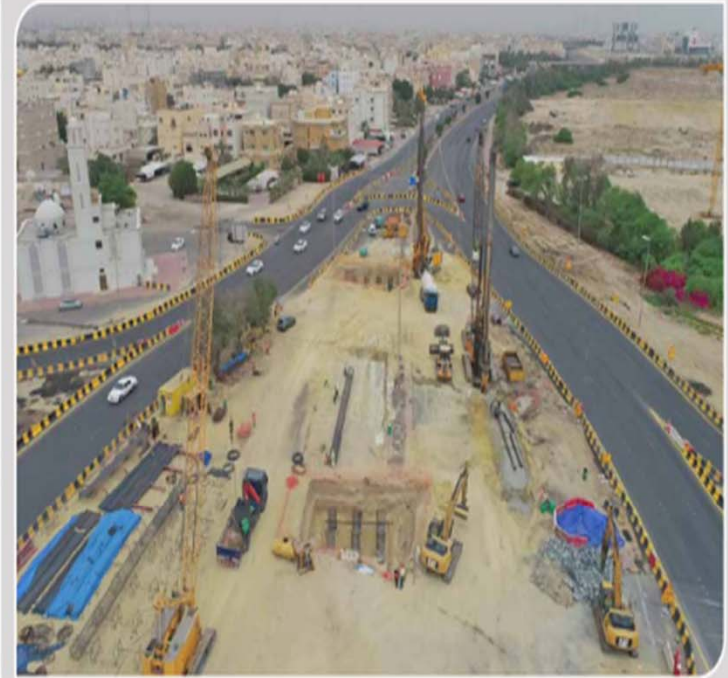
اعمال الجسور - أعمال الخوازيق بنقاطع 16
