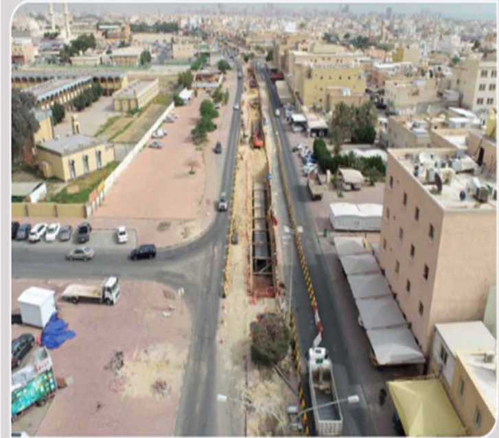
أعمال الخدمات- أعمال مجرور صرف مياه الأمطار بمنطقة الصباحية
