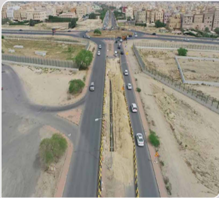
أعمال الخدمات- شبكة صرف مياه الأمطار بمنطقة الصباحية
