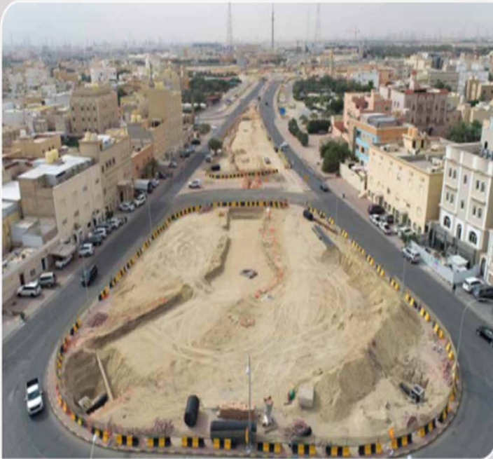
أعمال الخدمات - شبكة مياه الامطار - تمديد وتركيب الخطوط شبكة مياه الامطار بتقاطع 25 بمنطقة الصباحية
