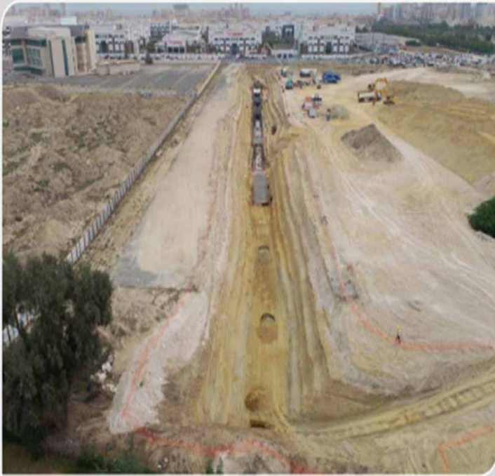
أعمال الخدمات - أعمال مجرور صرف مياة الأمطار بمنطقة العقيلة
