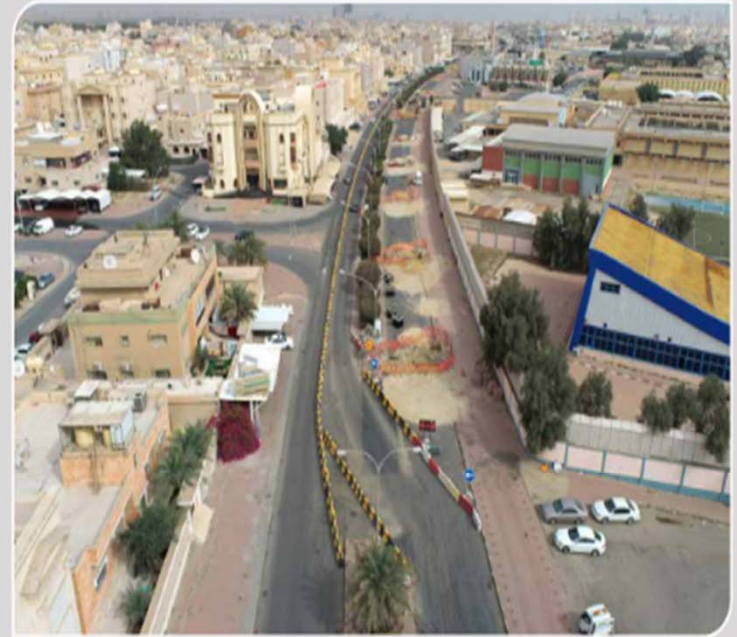
أعمال الخدمات- شبكة مياه الأمطار اعمال الجاليات بمنطقة الصباحية
