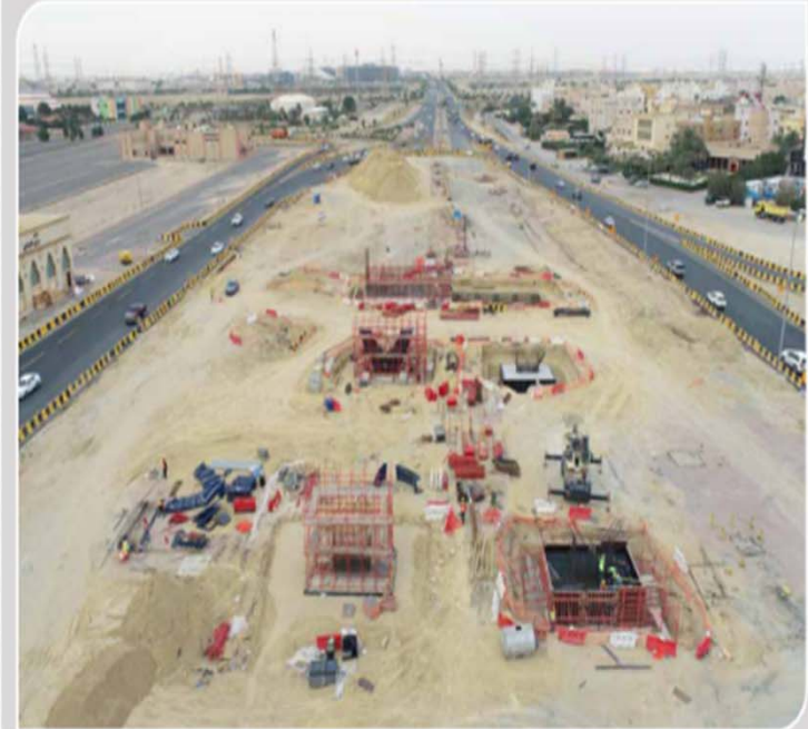
أعمال الجسور - اعمال قواعد أعمدة الجسور - بتقاطع 26
