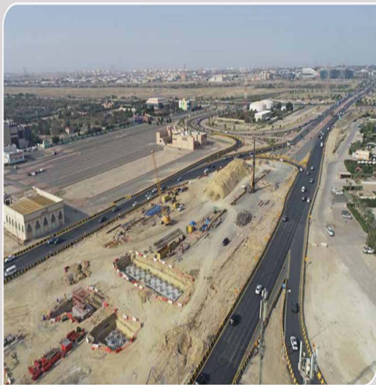
أعمال الجسور-اعمال القواعد- بتقاطع 26
