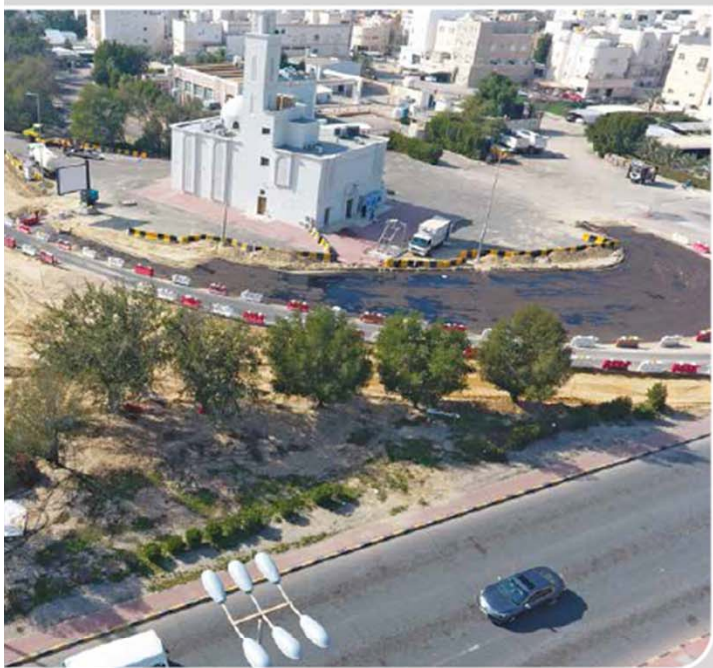
أعمال الخدمات- حفر مجرور صرف بمنطقة العقيلة
