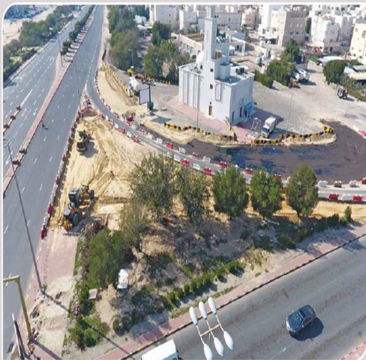
أعمال الخدمات- حفر مجرور صرف مياه الامطار بمنطقة العقيلة
