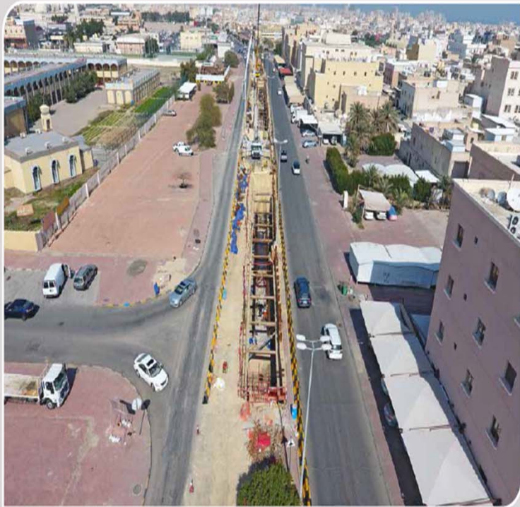
أعمال الخدمات - أعمال مجرور صرف مياة الأمطار بمنطقة الصباحية
