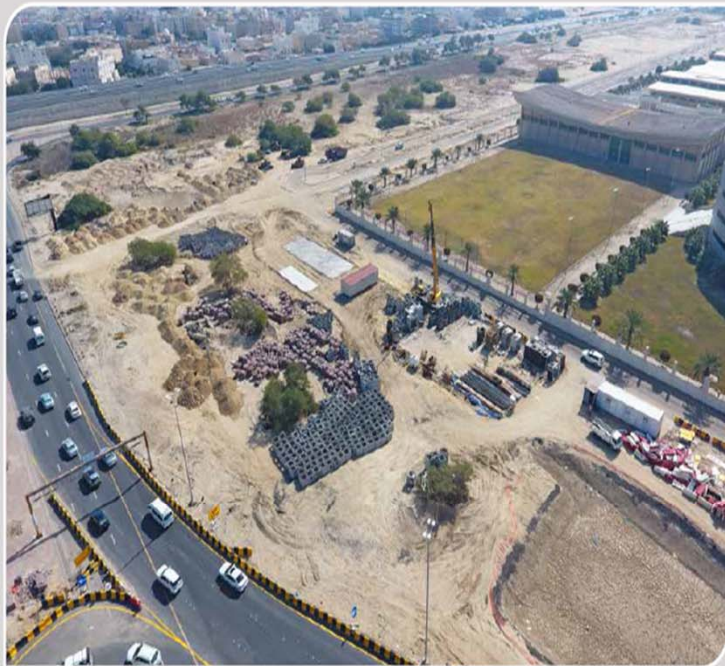
أعمال ساحة الصب وتشوينات لمواد المشروع بتقاطع 26
