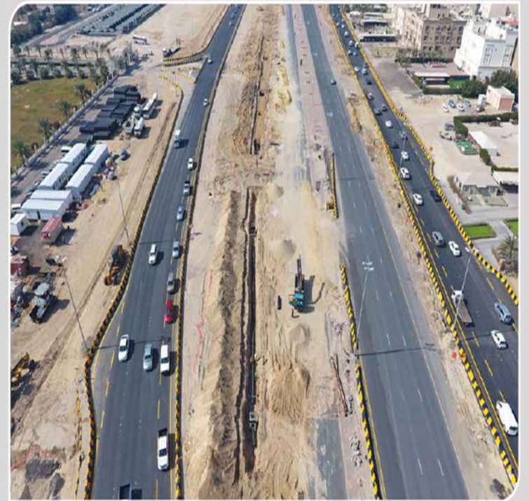
أعمال شبكة صرف مياة الأمطار بتقاطع 26
