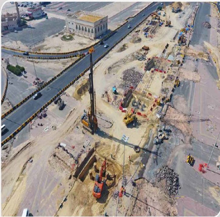
أعمال الجسور-اعمال الخوازيق - بتقاطع 26
